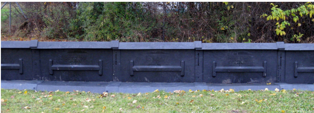
Abb. 1: Amphibienleitwand mit Lauffläche
